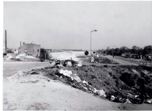
Aanleg spoor, rechts VVS
