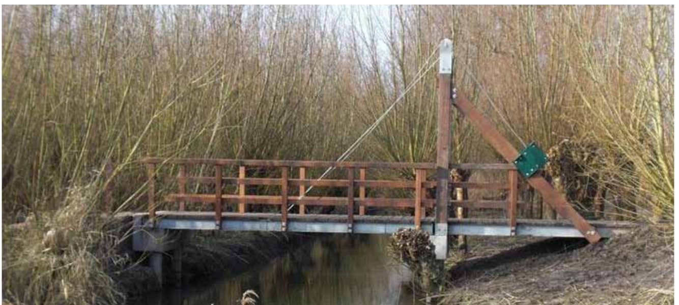
voorbeeld houten / stalen brug en poort
